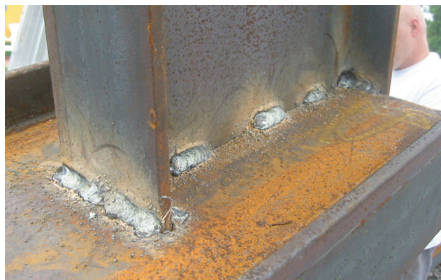
ნაკერების კლასიფიკაცია განფენილობის მიხედვით ა) ორმხრივ უწვევტი; ბ) ერთმხრივ წვევტილი; გ) ორმხრივ ჯაჭვური; დ) ორმხრივ ჭადრაკული. 1 – ნაკერის სიგრძე; t – ბიჯი.
