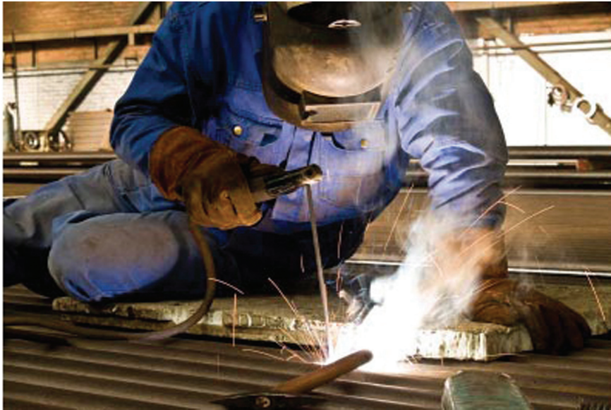
შემდუღებელი ლითონის კონსტრუქციის ზედაპირზე მჯდომარე მდგომარეობაში მუშაობისას იყენებს დენგაუმტარ ქვესადებს
